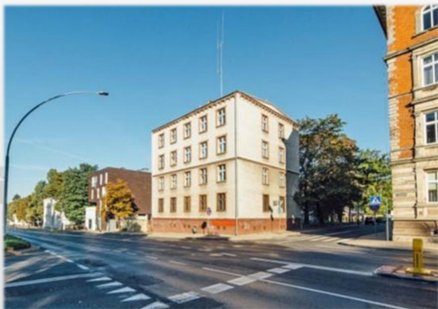
Budynek przy ul. Zwycięstwa 111 – stan obecny
