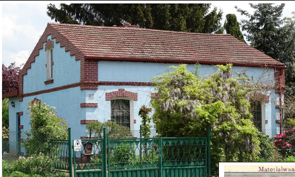
Widok ogólny od płn.-zachodu
