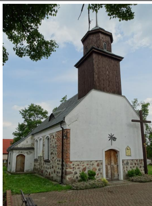
Widok ogólny od płn.-zachodu
